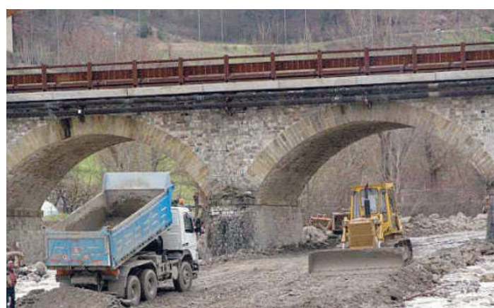
I lavori in corso sotto il ponte del Perino lungo il vecchio tratto della Statale 45 a Perino
