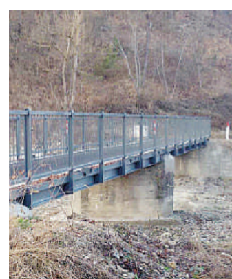
PIOZZANO - Il ponte della Regola dopo l'intervento di sistemazione (foto Bersani)
